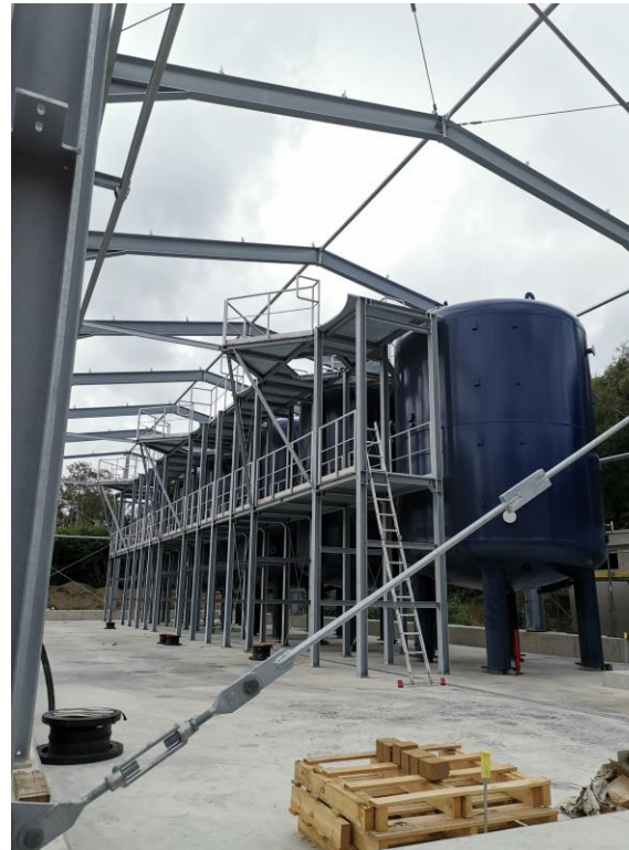
KA Gütersloh Putzhagen
