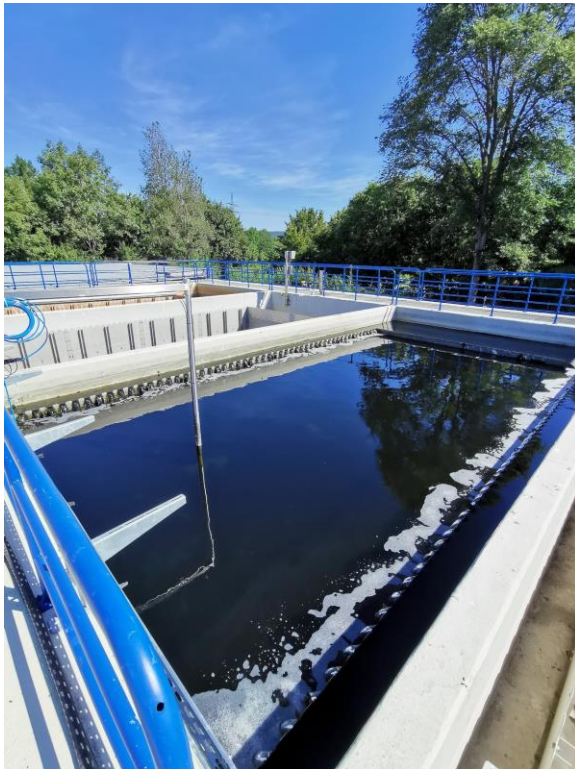
KA Bad Oeynhausen
